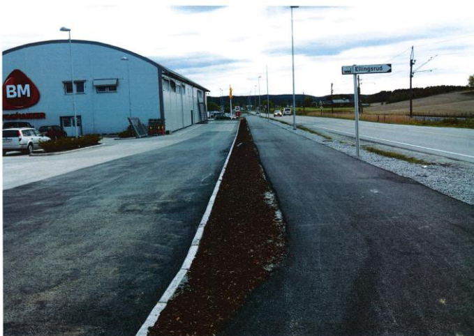
Ferdig gang-/sykkelveg over ledningstraseen langs Kjeppestadveien.
