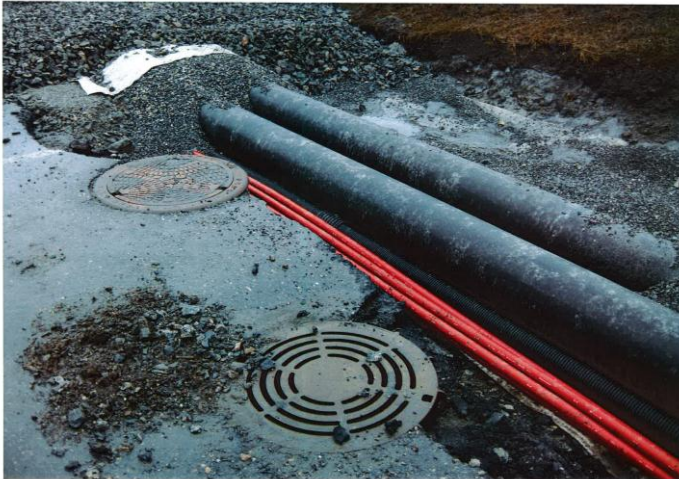
Ledningstrase med omfylling.
